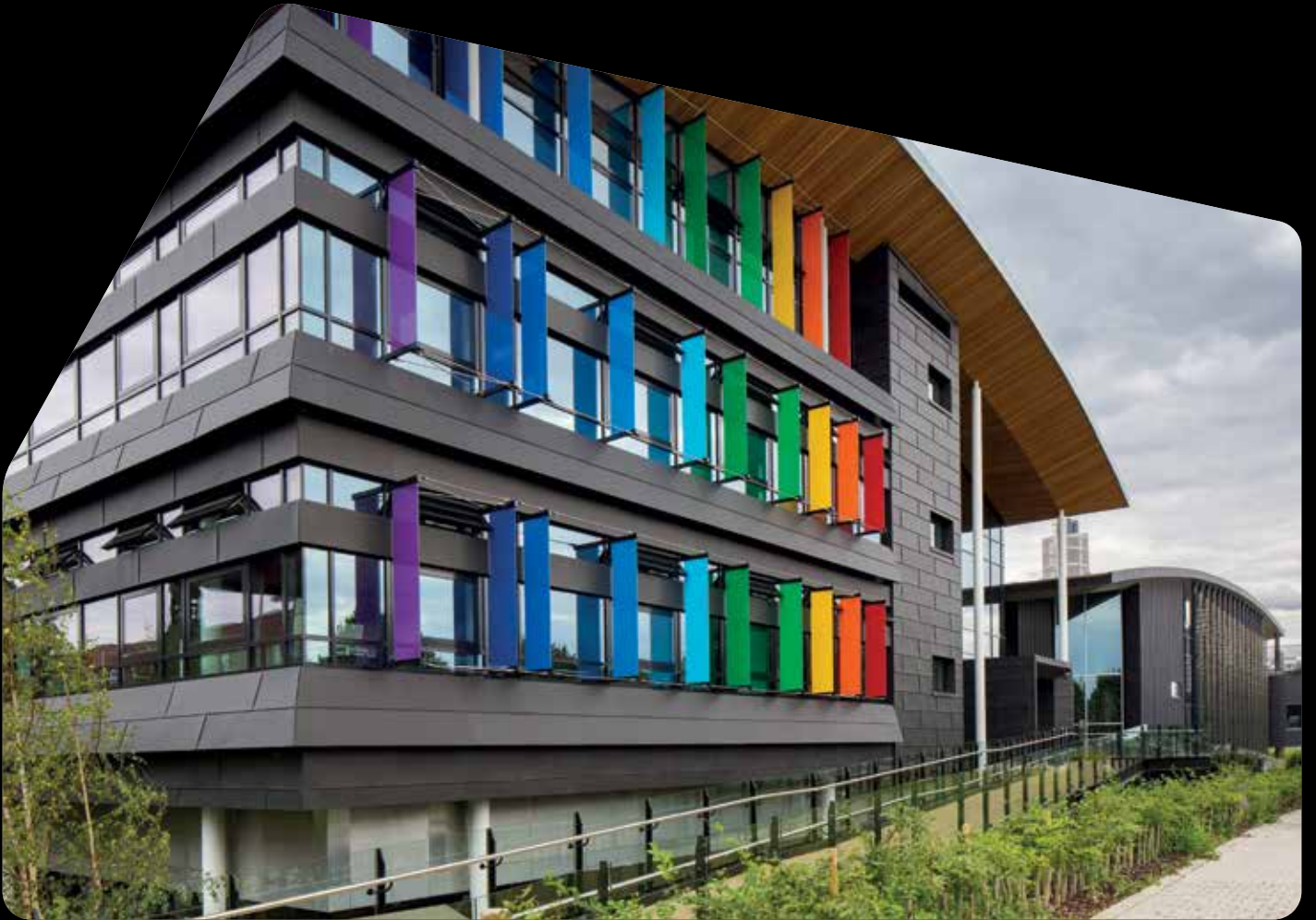
BREEAM • University of Cambridge Maxwell Centre • Architecte : Building Design Partnership (BDP) • Cambridge (Royaume-Uni)
