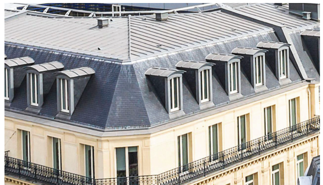
Toitures "à la Mansart"
